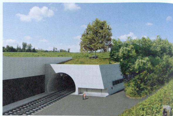
Das Ostportal wird als scharfer Einschnitt in die Böschung des alten Bahntrassees ausgebildet. Lärmschutzelemente aus schwarzem Lavabeton tragen dazu bei, die Stützmauer besser in die Landschaft zu integrieren
