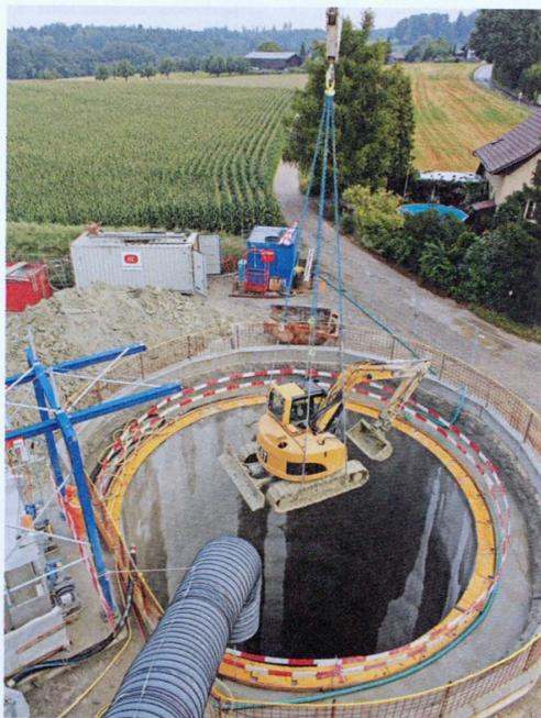
Der acht Tonnen schwere Bagger wird zweimal pro Woche mit dem Kran in den Schacht gehievt
